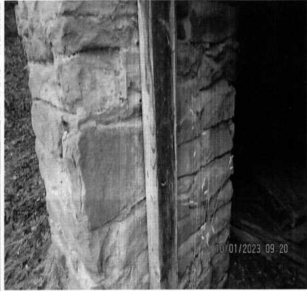
Wejście do podpiwniczenia - resztki ościeżnicy
