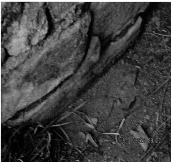
Kamień do oczyszczenia i impregnacji, brak płytki odbojowej
