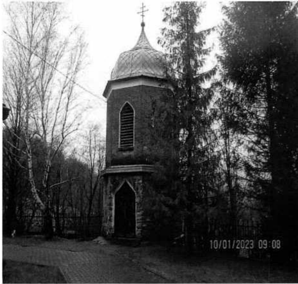
Widok od strony frontowej - kościoła.
