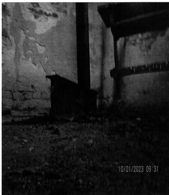
Podparcie konstr. dzwonu do wymiany
