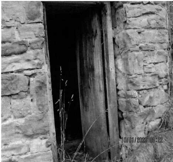
Drzwi wejściowe do podpiwniczenia
