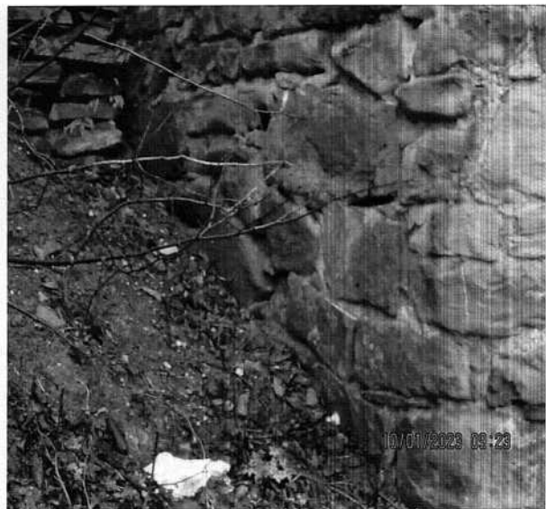
Kamień do oczyszczenia i impregnacji, brak płytki odbojowej
